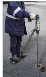
Exemple d'utilisation sur une vanne enterrée
